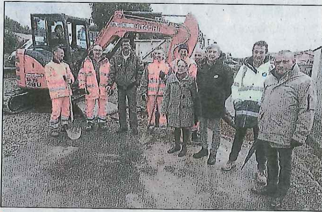
► La route de Quarante en travaux.
